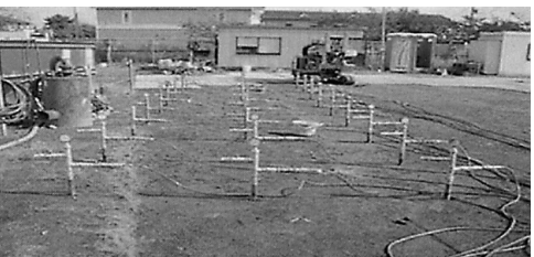
多点同時注入工法による注入状況①と化学酸化剤注入のイメージ図②
