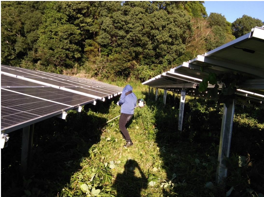
防草対策施工前の太陽光パネルの状況
