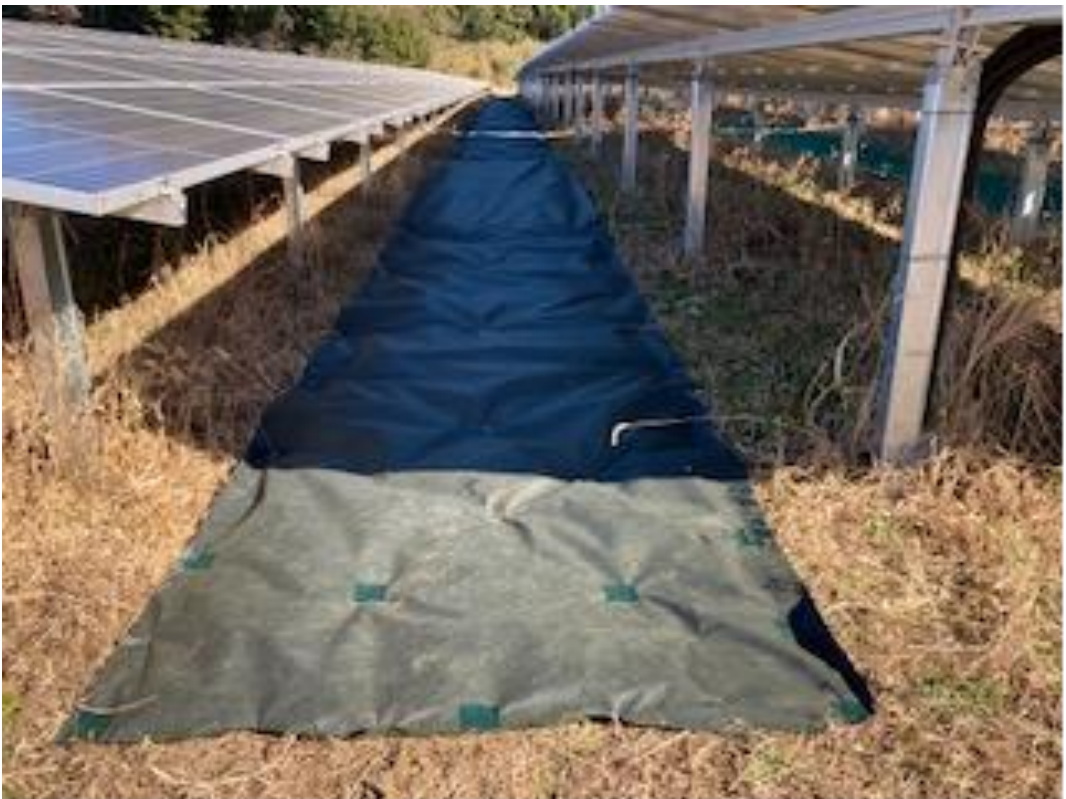
防草シート敷設完了状況
