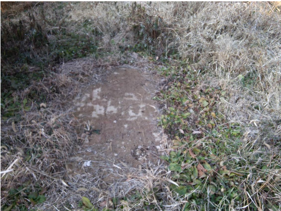
竹チップにマグネシウム系固化材を混合した改良材で表面被覆
