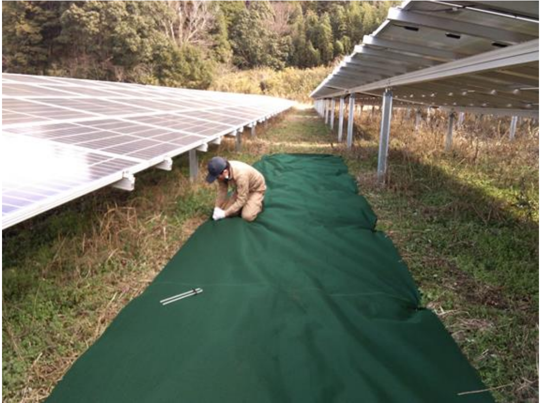
防草シートの敷設状況
