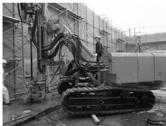
写真4 ダブルパッカー施工状況
