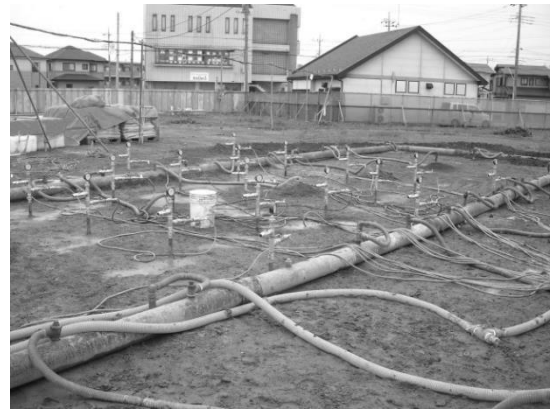
写真7 フルアップポイント工法 施工状況
