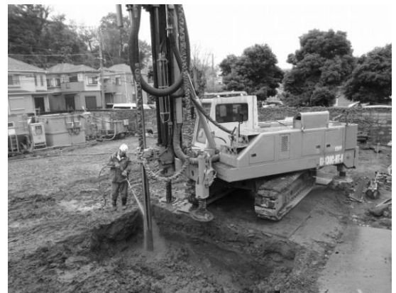
写真3 柱状改良機によるフェントン反応剤の攪拌混合
