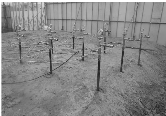
写真5 フェントン反応剤注入状況
