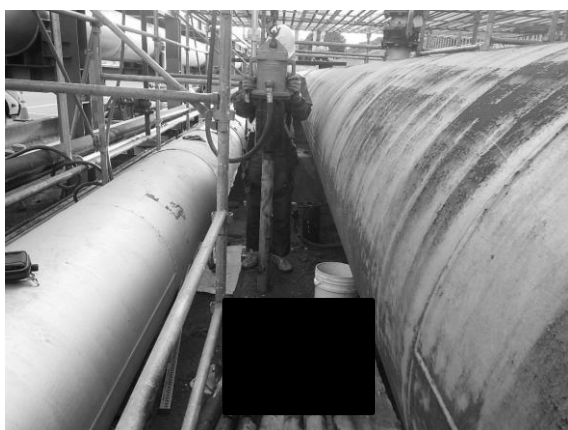
写真6 狭い敷地内での施工状況
