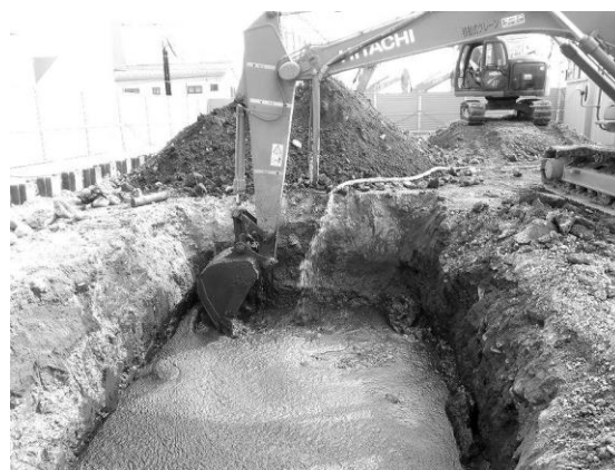
写真1 バックホウによるフェントン反応剤攪拌混合
