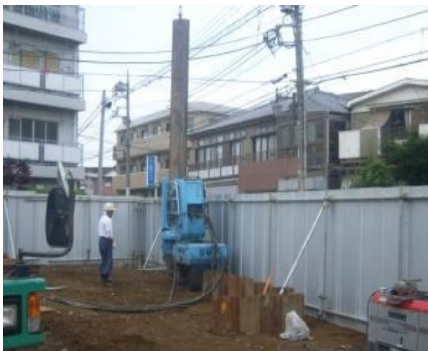
シートパイル打設
