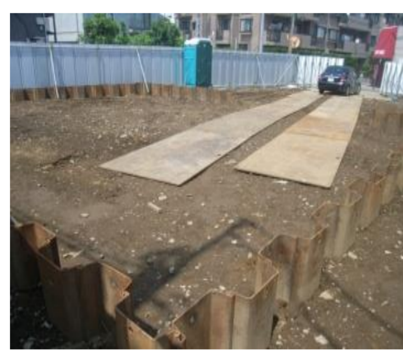
シートパイル設置
