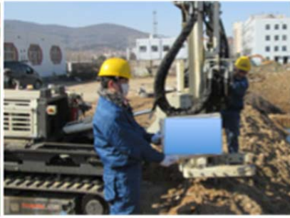
写真-8 ポーリング状況
