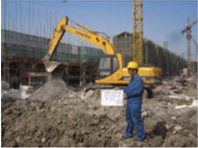
写真-4 浄化作業全景
