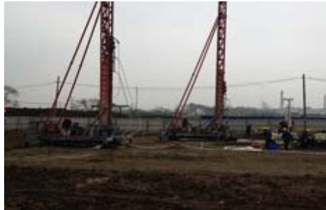
写真-2 施工状況 深層混合双方向攪拌機等
