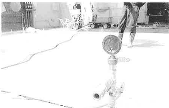
写真3 消臭剤の注入
