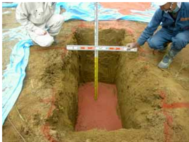
写真-1 人工地盤作製状況
